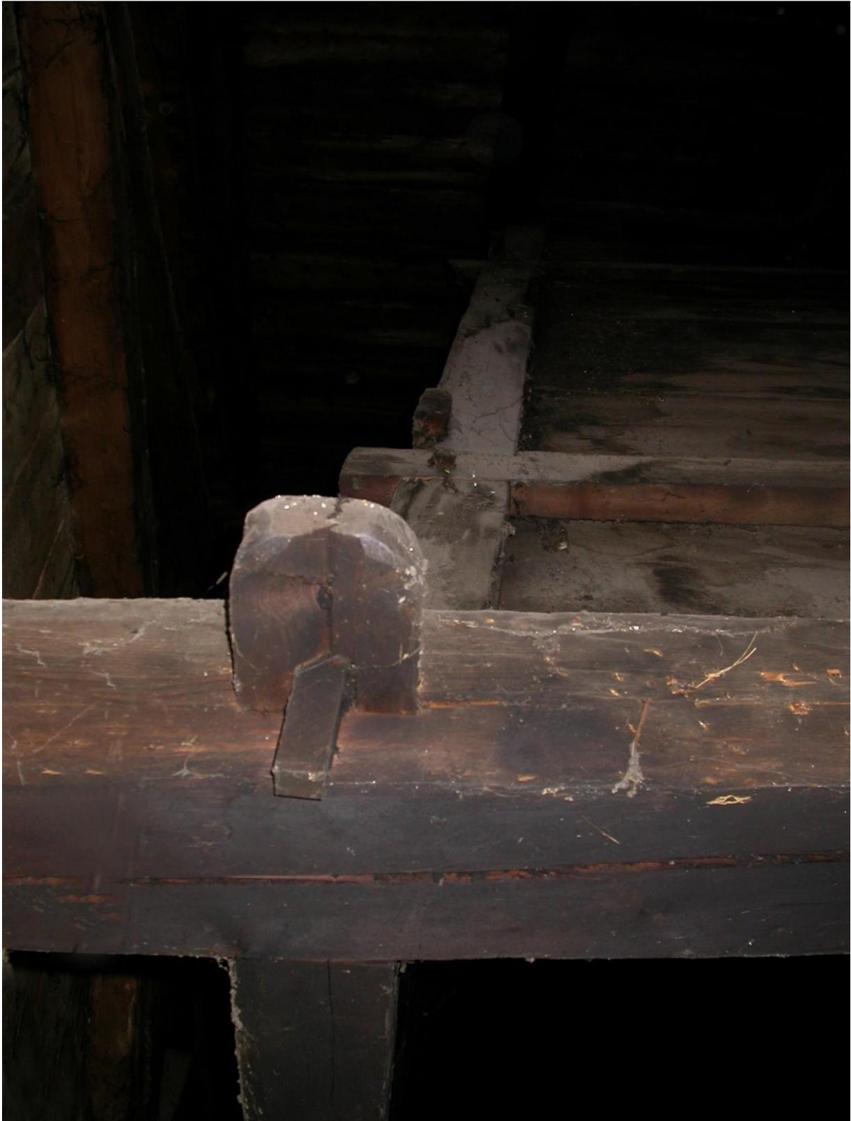
Jointure de deux poutres à l'angle.
