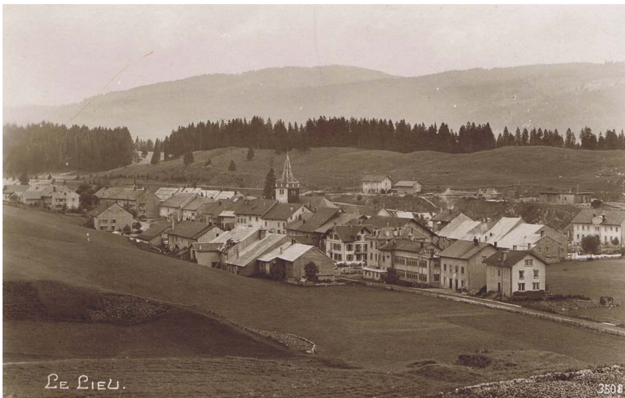
Plateforme du site dit Le Vieux Moutier, là où se serait trouvée la première église du village. La partie en pente côté sud, était essentiellement composée de jardins.
