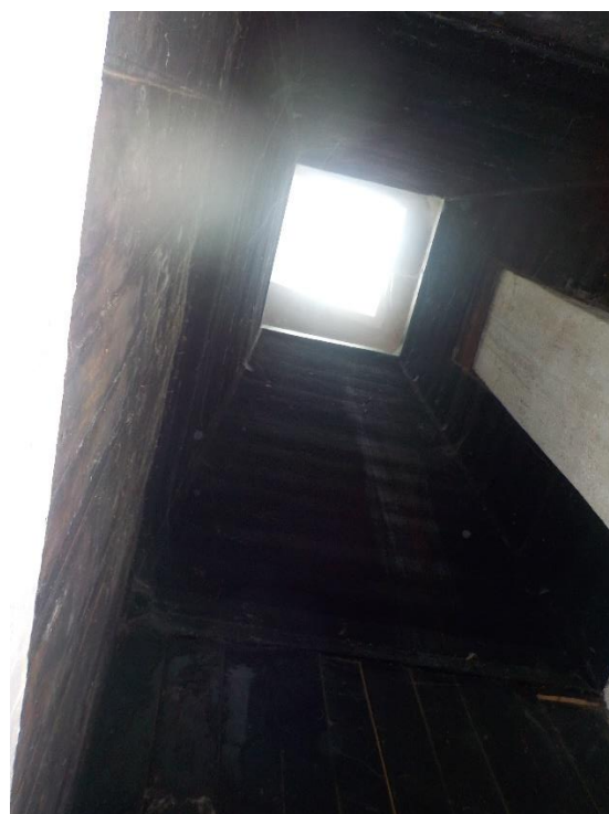
Au cœur de la maison, la grande cheminée qui offre aujourd'hui un timide puits de lumière.
