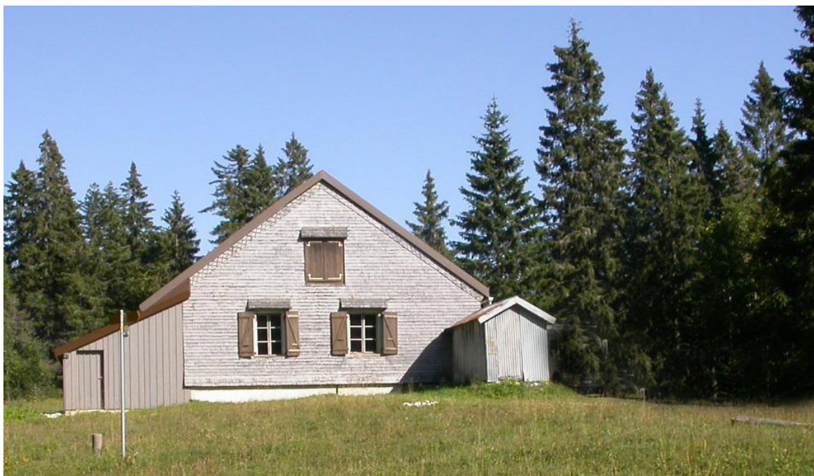
Le Poste des Mines, au cœur du Risoud, proche de la frontière.
