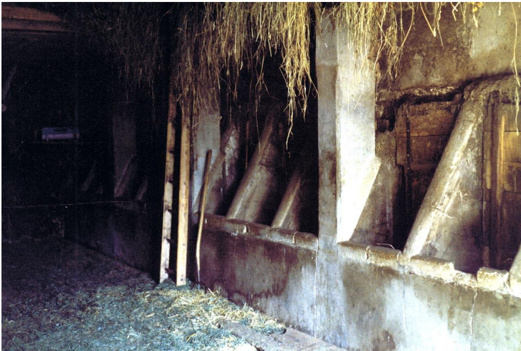
Fourragère et grange tout en même temps, les crèches, et sous la paille, les planches.
