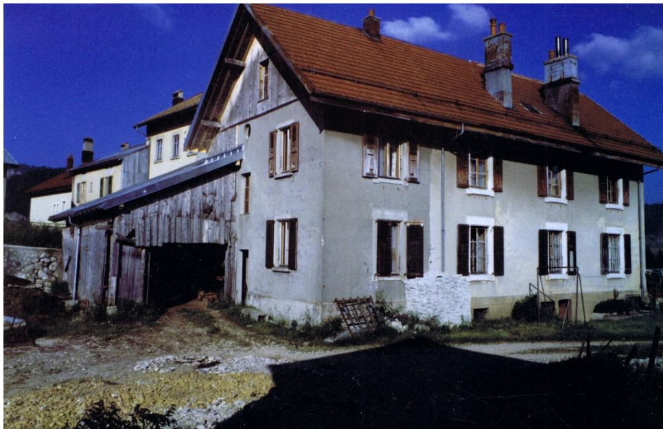
Façade ouest et arrière de la dite maison, voisine de chez Jules-Jérémie. Construction de 1901, suite à l'incendie du Haut-du-Village en septembre 1900.
