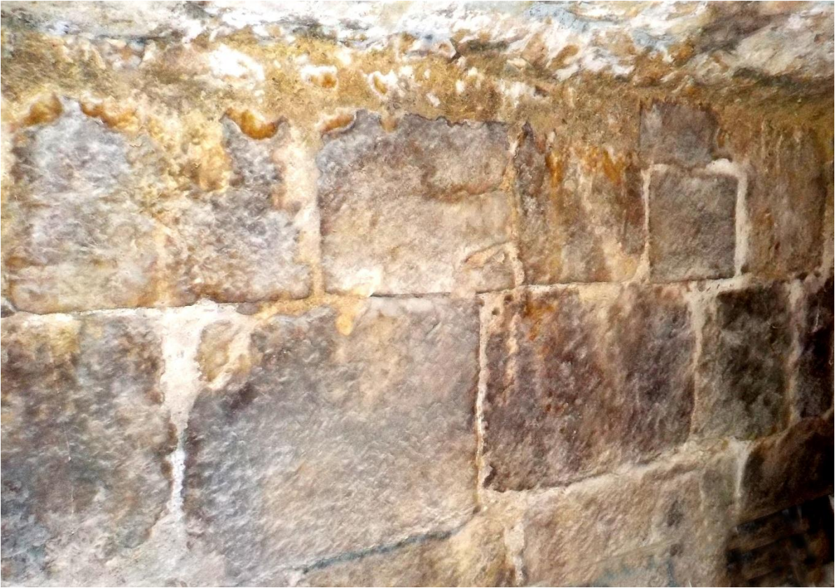
Le mur d'une cave au fond du corridor, prouve une ancienneté remarquable par le volume des pierres et leur état de vétusté.
