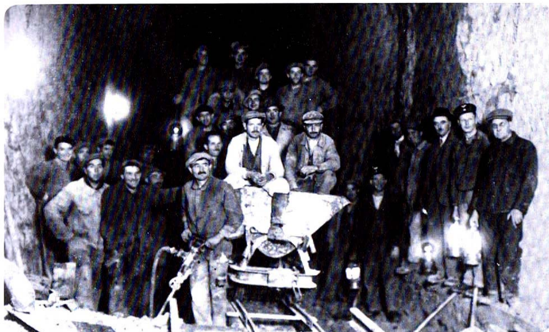
Fig. 17 Approfondissement du tunnel pour permettre l'électrification. (Photo Locatelli, Le Pont; coll. R.R.)
