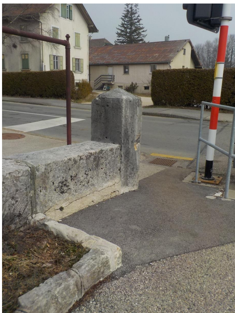
Tête de mur côté bise, à proximité du passage à niveau.
