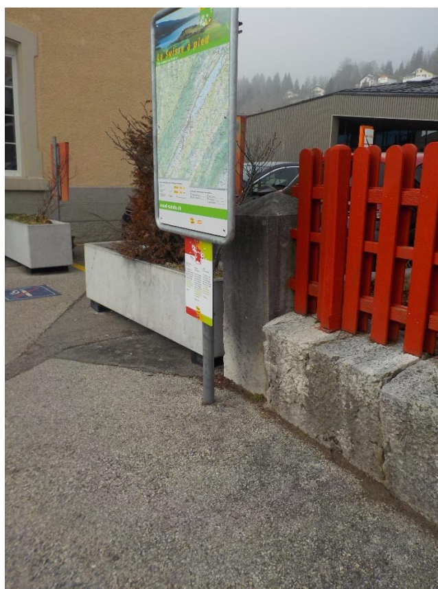
Tête de mur côté vent.
