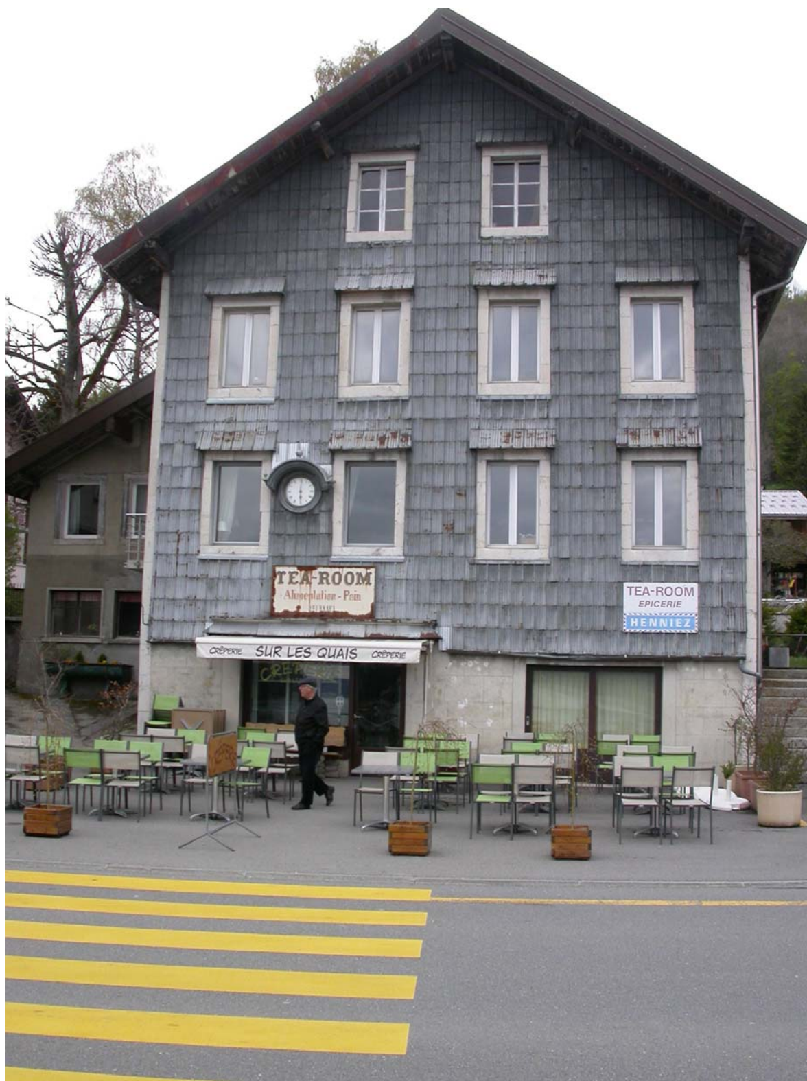
L'ancien bâtiment école-boulangerie le 30 avril 2014.
