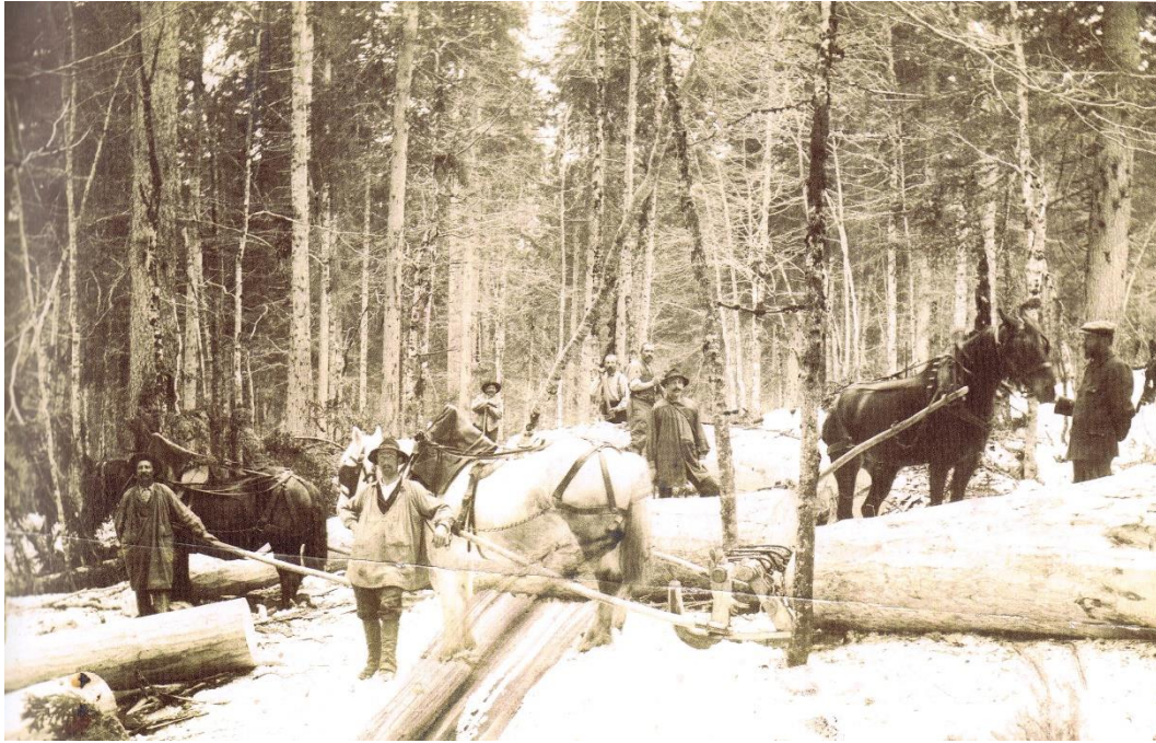
Risoud, 1910. On débarde le plus souvent en hiver. Les plots glissent mieux sur la neige que sur le terrain.
