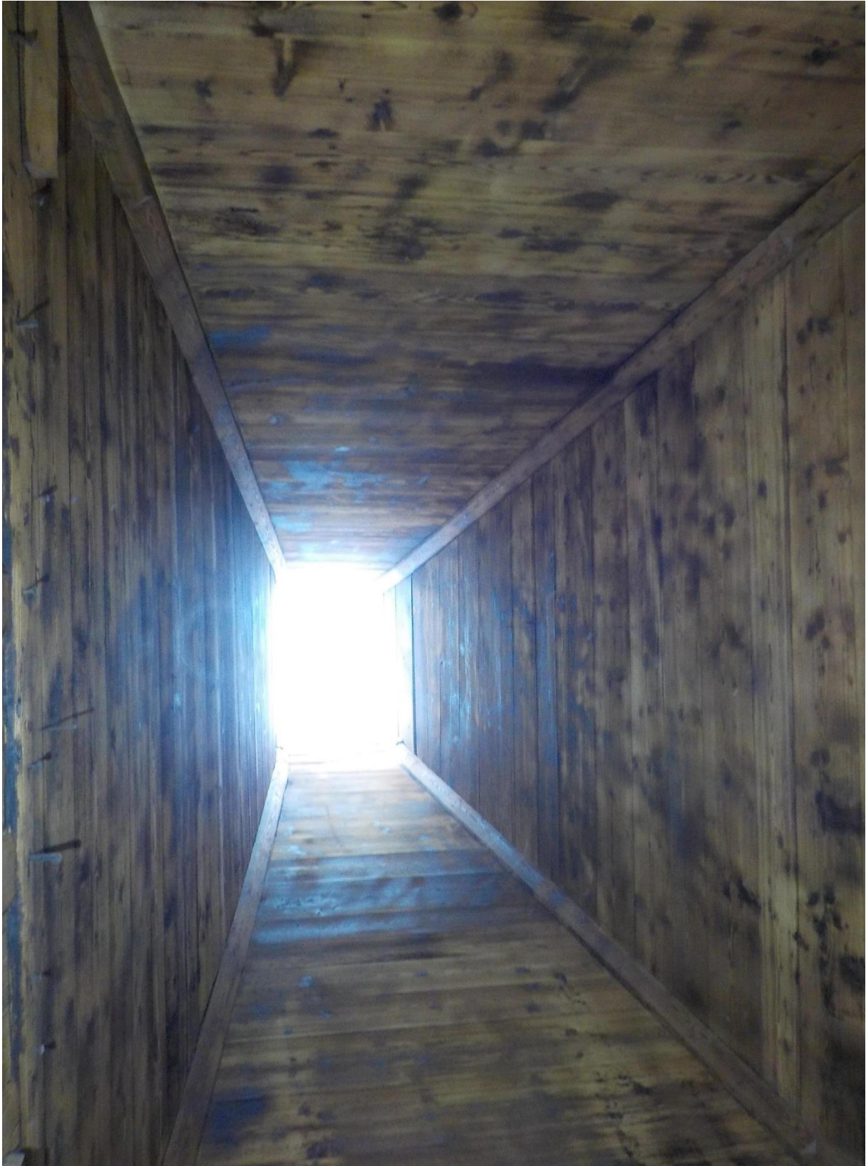
La grande cheminée des Mollards sur le Brassus. Elle a été sablée.
