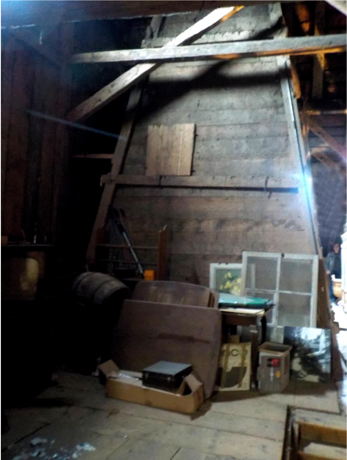
Grande cheminée de la maison Clerget à l'Abbaye.
