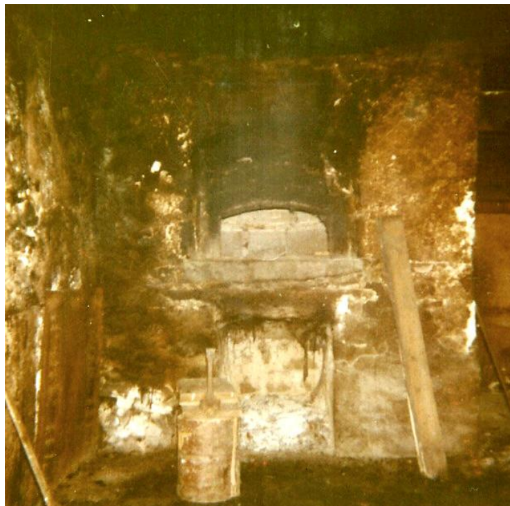
Le four. A gauche, la plaque arrière de la cheminée, chargée de chauffer la chambre se trouvant derrière. Au premier plan un banc à enchapler.
