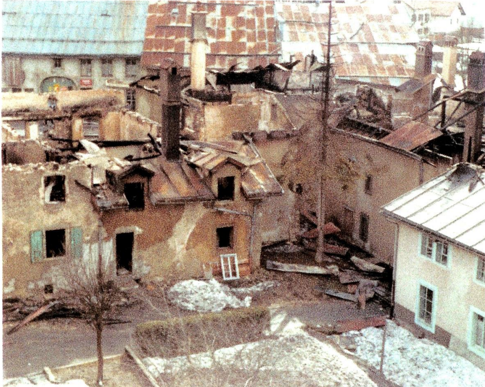
Même point de vue du haut de la tour, cette fois-ci les jours d'après l'incendie.
