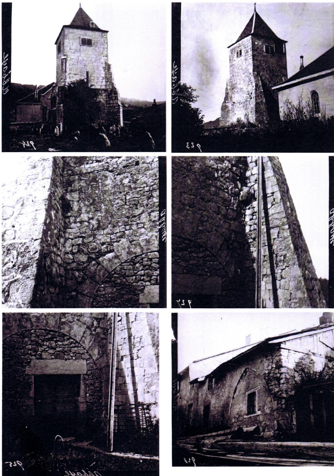
Fig. 37 à 42. Photographies réalisées par Van Berchem lors de sa visite avec A. Naef en 1899. ACV, AMH C 1145.
