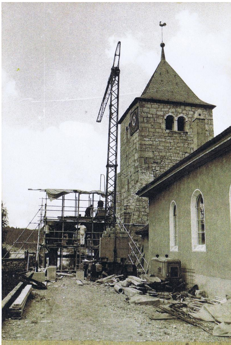
Reconstruction de l'arche en 1971.
