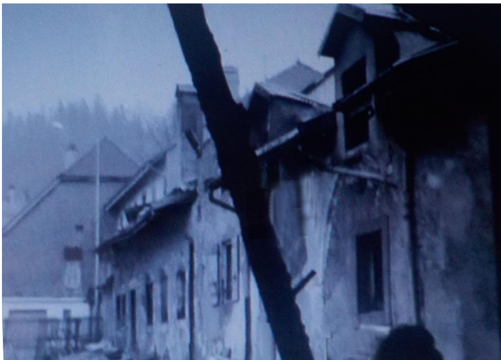
Image extraite d'un film qui semblerait avoir été pris sitôt après l'incendie par la TV Suisse romande. On voit ici une bonne partie de l'arrière de maisons qui seront bientôt disparues. Au fond, l'Hôtel de Ville.
