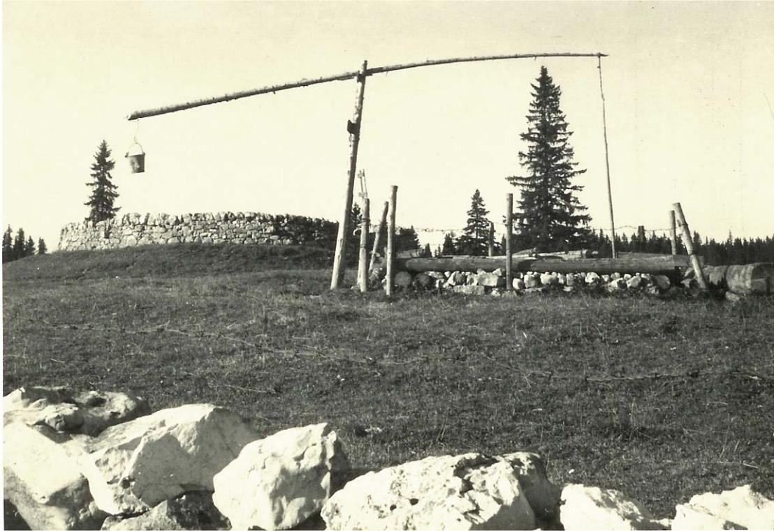
Le fléchissement de la grande perche varie en fonction du poids des éléments. Ici, comme cela se faisait aussi couramment, la grosse pierre a été remplacée par un vieux bidon de fer blanc – il avait fini par rouiller et par se percer, donc inutilisable au chalet pour le transport de l'eau – que l'on remplit de pierre. Veiller tout de même à ce que le fond soit suffisamment solide pour accueillir le poids de 15 à 20 kg de cailloux.
