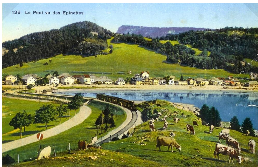
La Combe et le bord du lac, communaux pour le village des Charbonnières. Ici aux Epinettes.
