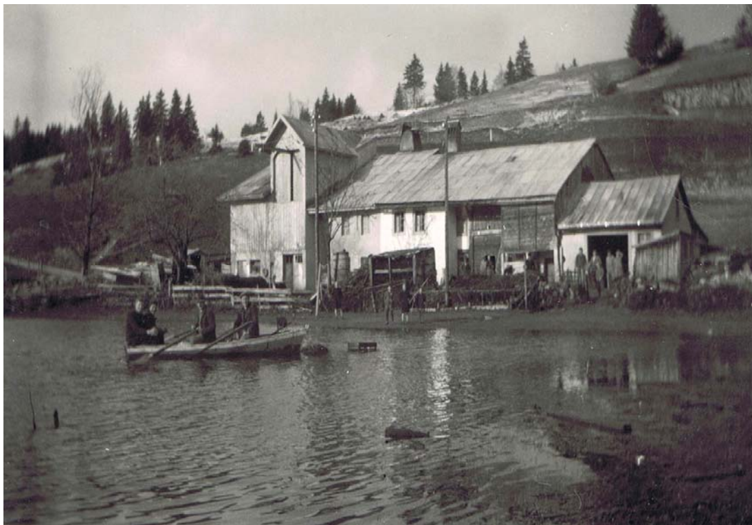
Inondation de novembre 1944. Un voisinage qui existait déjà en 1814. La grange de droite a été rajoutée ultérieurement. La maison de gauche est celle des Lugrin, celle de droite celle de Nono, soit Arnold Golay.
