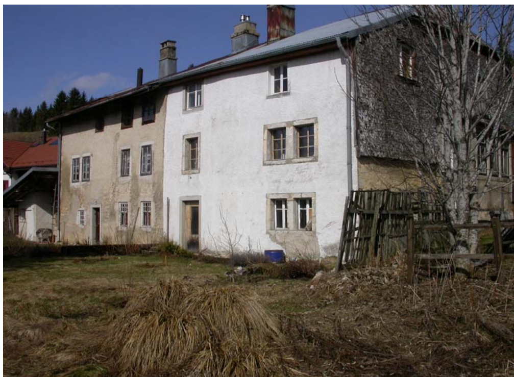
Arrière de la maison de Charles-Louis à gauche, et arrière de celle de la famille Meylan industriels à droite, avec les fenêtres de l'ancien atelier au rez.
