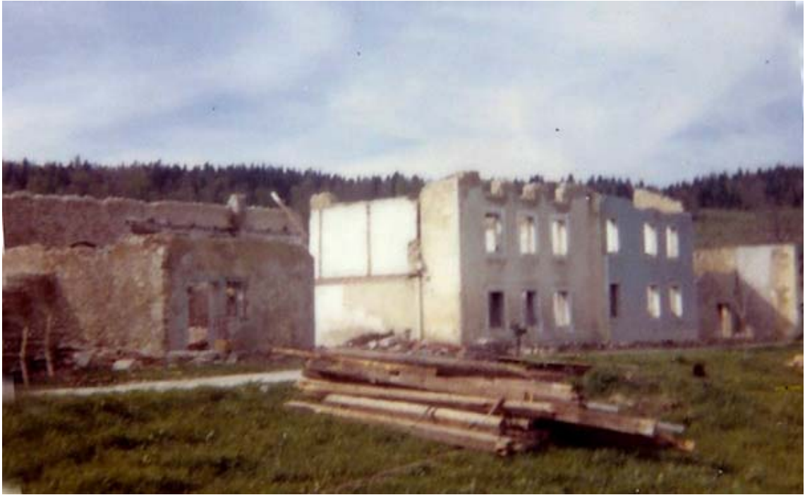
La meilleure manière de supprimer des néveux, c'est encore de démolir les maisons ! Années soixante.
