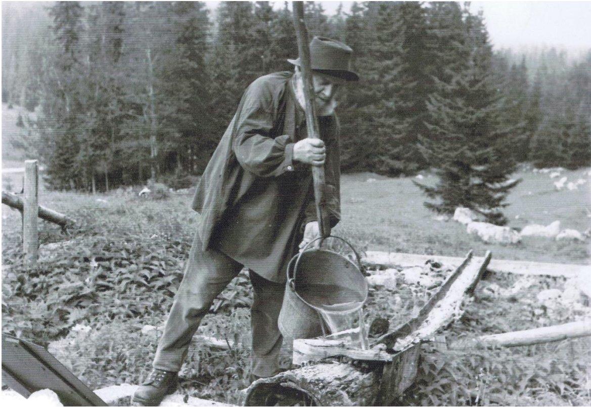
A la Givrine. Le berger utilise le balancier pour remplir le bassin sous-jacent grâce à une coulisse de bois. Photo Daniel Aubert, Le Brassus.
