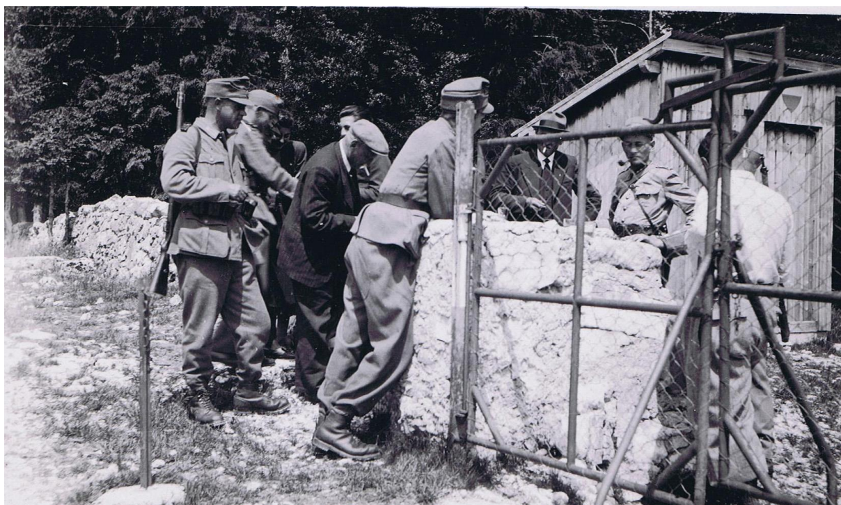
Le clédar de fermeture du Poteau pendant la dernière guerre mondiale. Depuis lors complètement dégradé pour être entièrement reconstruit par l'ARMUR en 2022-2023.
