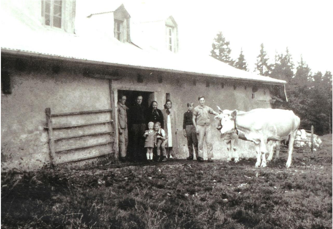
Clédar de la porte d'écurie. Celui de l'entrée était tout pareil. Perche horizontale fixées dans deux piliers verticaux.
