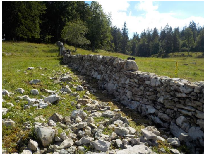
Le chantier du deuxième segment.
