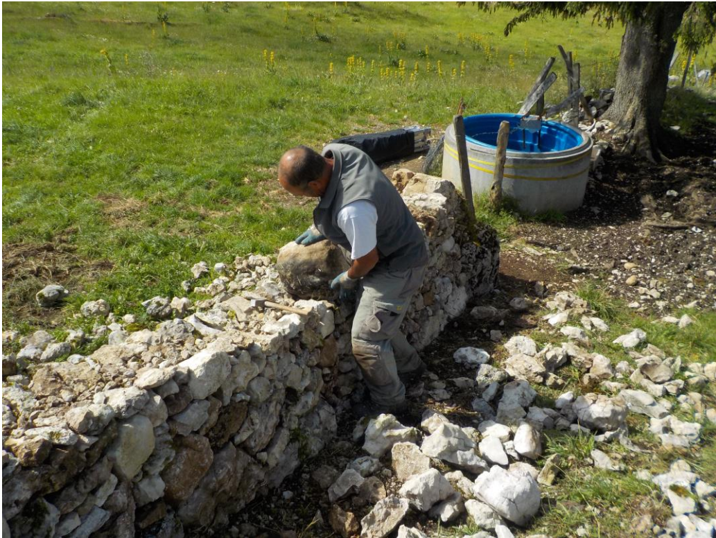
Les couvertes sont lourdes pour le muretier Yves Jeanneaux !
