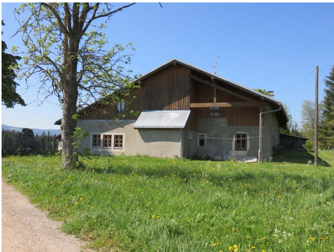
Pignon de bise du voisinage.
