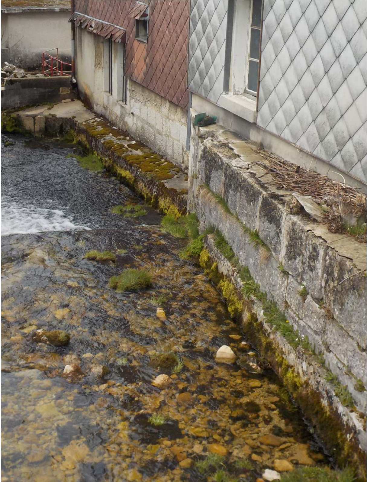
Des maisons posées sur de solides murs de pierre à défaut de pilotis !
