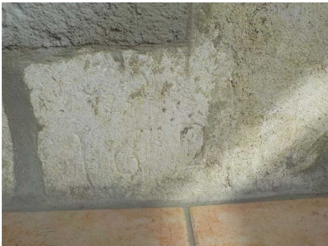
Pierre de réemploi située au bas de la façade orientale.
