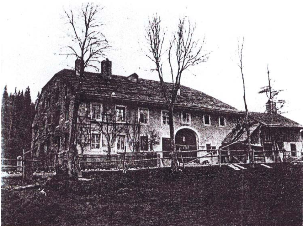
La maison familiale construite en 1803
