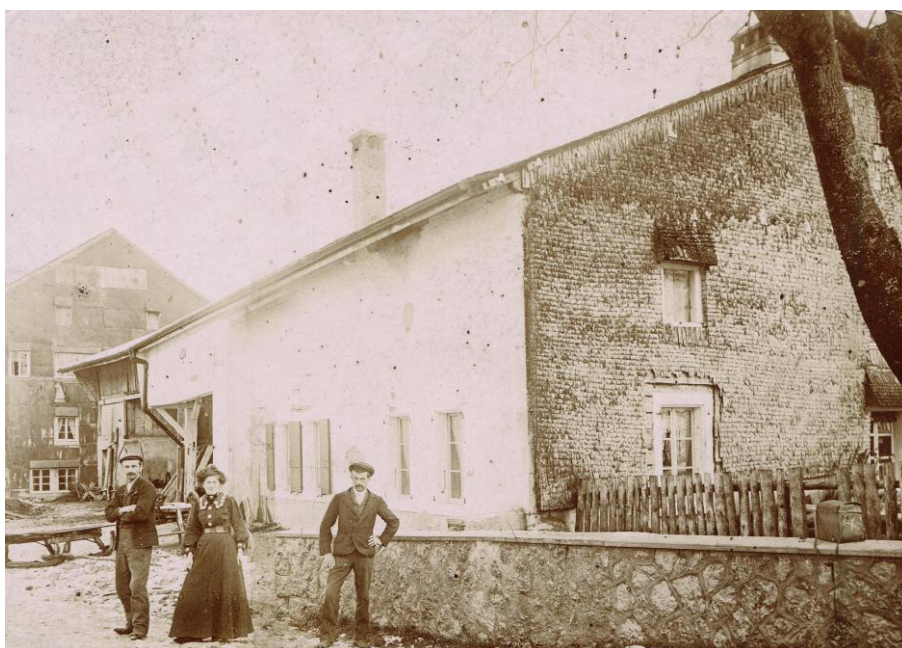
Maison du Vieux-Cabaret aux Charbonnières. Il existait encore il y a quelques années seulement un néveau côté route, et un néveau côté jardin. Celui-ci a été proprement massacré.
