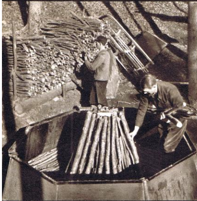
Un four à charbon de bois en cours de chargement.
