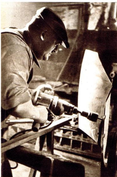
Les vieilles charrues sortent des granges et le forgeron les remet en état. Il a modernisé son installation et l'électricité lui est désormais une aide précieuse. On le voit travailler ici avec une perforatrice à main.
