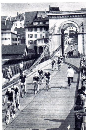
Sur le pont suspendu d'Aarau.
