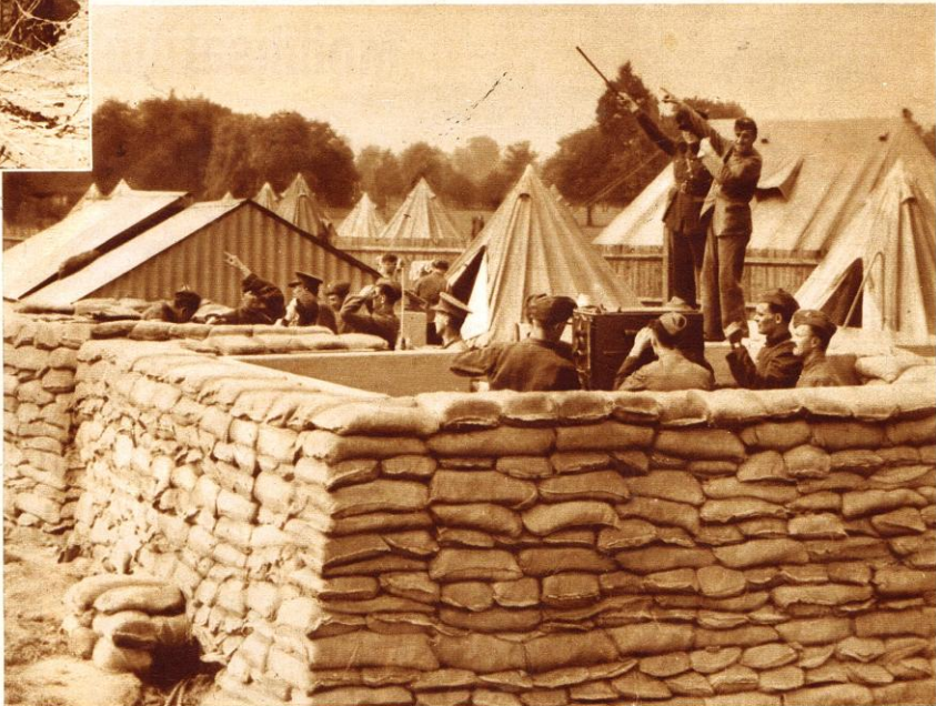
L'activité de la D. A. P. à Londres : construction d'un rempart de sacs de sable comme précaution contre les bombardements. (Keystone)
