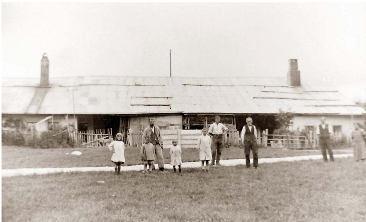
La Frasse. C'est dans de telles fermes que l'on procédait aux travaux du boisselier. On pouvait travailler en partie sous le néveau. Cette maison existe encore aujourd'hui, peu changée.
