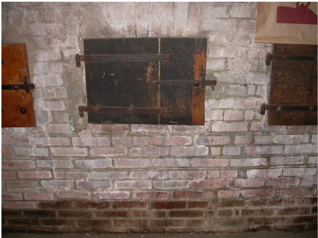
Un volet de crèche vu à la fourragère. L'apparition de murs en briques n'est naturellement pas d'origine alors que tous les éléments de la grange et de l'écurie étaient en bois.
