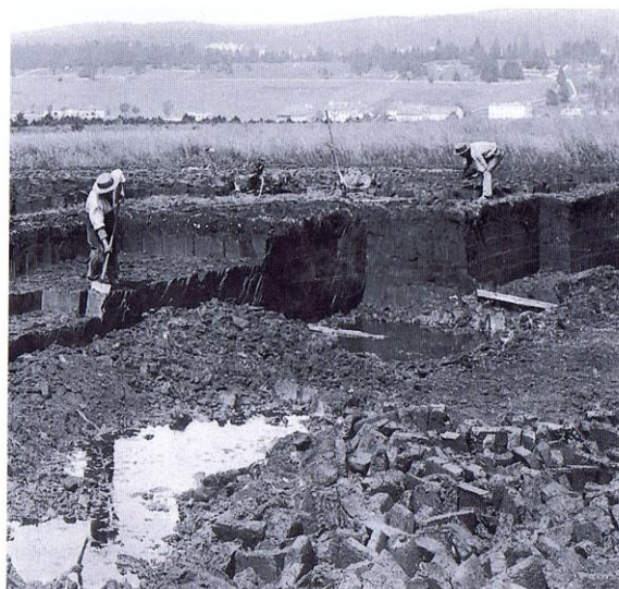
Figure 22. Louchet à tourbe. Sorte de pelle à couteau latéral pour débiter la masse en briques régulières. Long. totale: 130 cm, long. du fer: 36 cm. A droite, ouvrier tourbier, d'après une ancienne carte postale.
