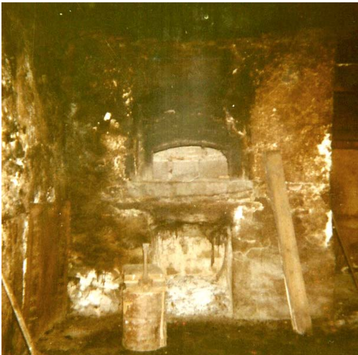
Le four. Devant un plot à enchapler. A gauche, la plaque de cheminée dont le revers brûlant servait à réchauffer la chambre « devant », dont on peut découvrir les fenêtres sur les photos précédentes.
