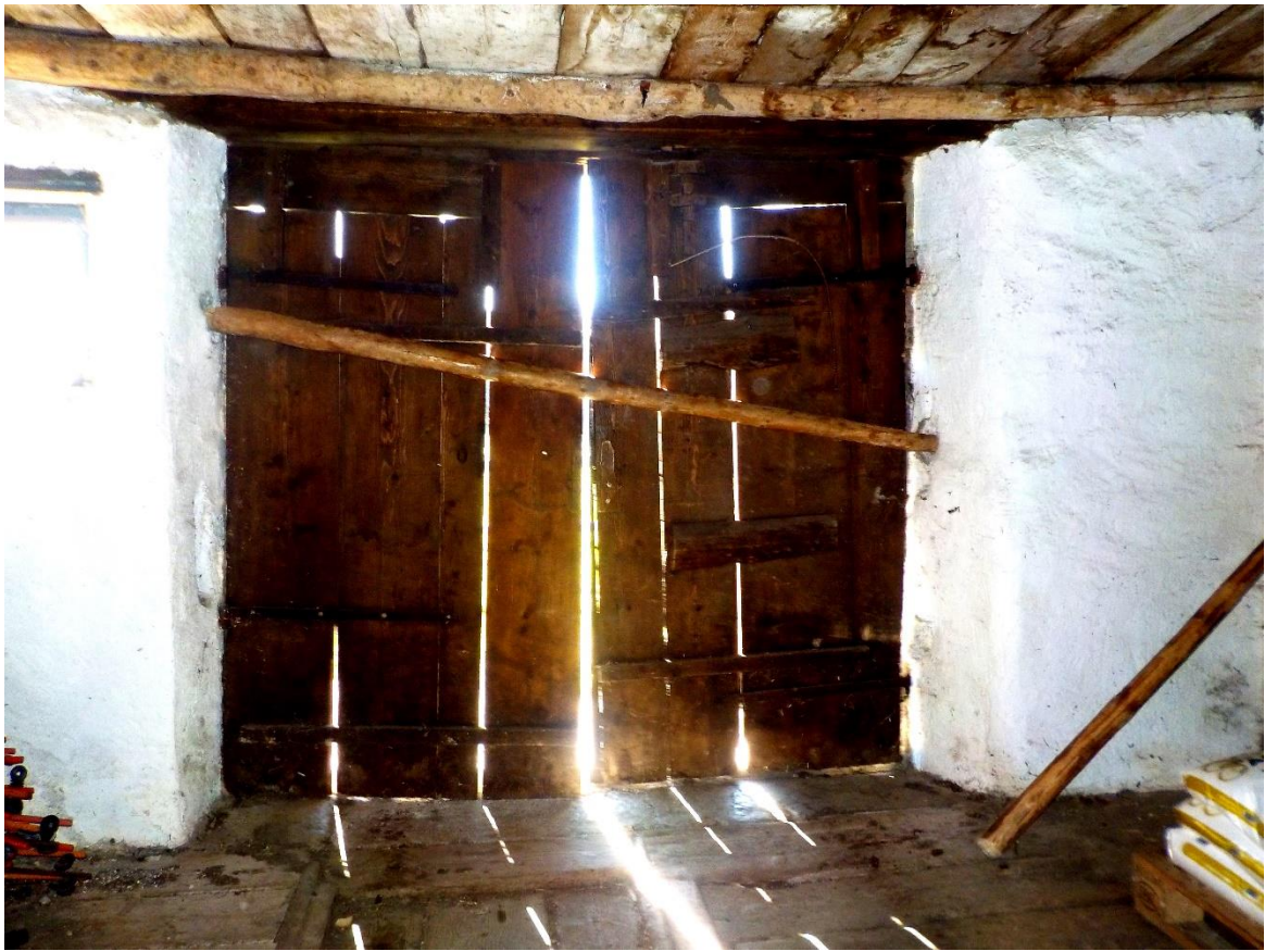
Une porte d'écurie qui a vu de l'air.
