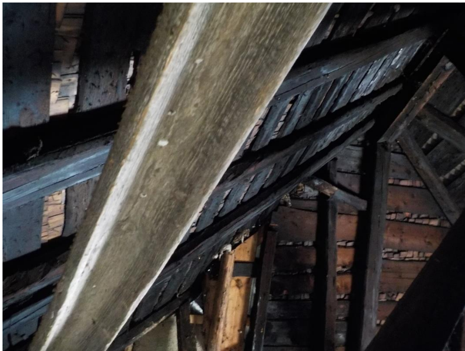
Une ancienne cheneau et la charpente.
