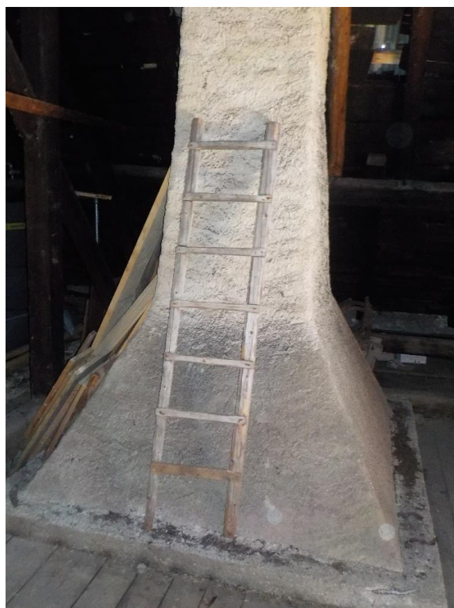
La cheminée, reconstituée en béton par les propriétaires après que le chalet voisin ait brûlé.
