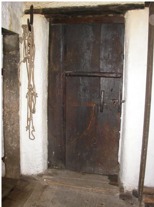
La porte entre la cuisine et l'écurie est une vraie antiquité, pivotant en haut et en bas par des axes taillés directement dans la planche du bord gauche qui est plus épaisse. Le péclet est aussi d'un système particulier, permettant d'ouvrir aisément la porte autant depuis un côté que de l'autre.
