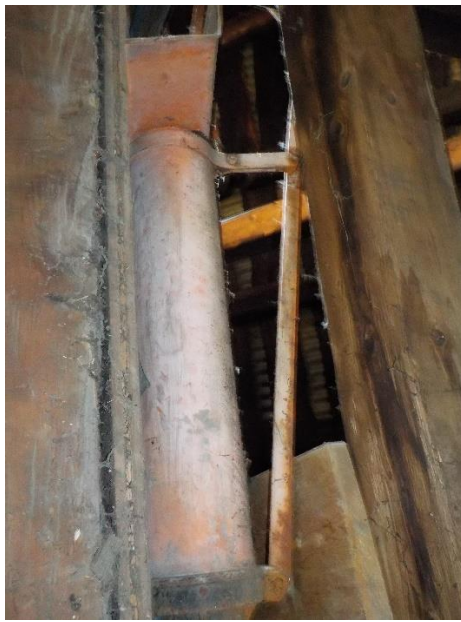
Ancienne pompe à piston.
