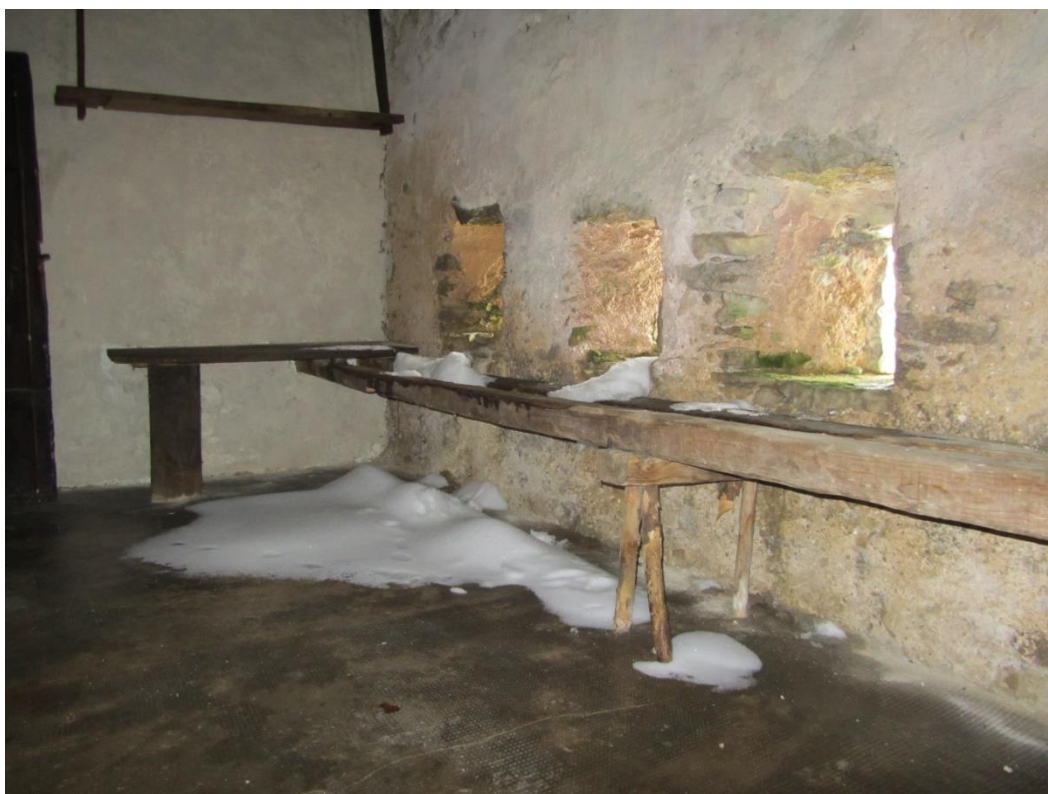
Les mats côté nord, en plein hiver. C'était sur ces poutrelles de bois que l'on posait les baignoires contenant le lait mis à rafraîchir pendant la nuit, avec levage de la crème le matin avec la poche.
