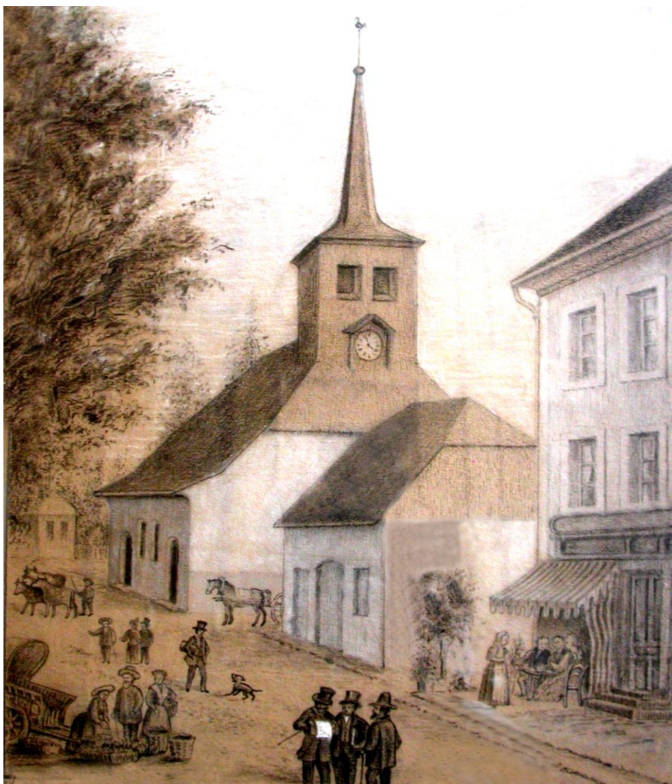
Dessin d'époque figurant dans les archives du Patrimoine de la Vallée de Joux. Le temple brûla le mercredi 23 mars 1798, à 11 heures du soir. Le coq est parfaitement visible sur ce dessin restituant vraiment toute une ambiance d'époque.
