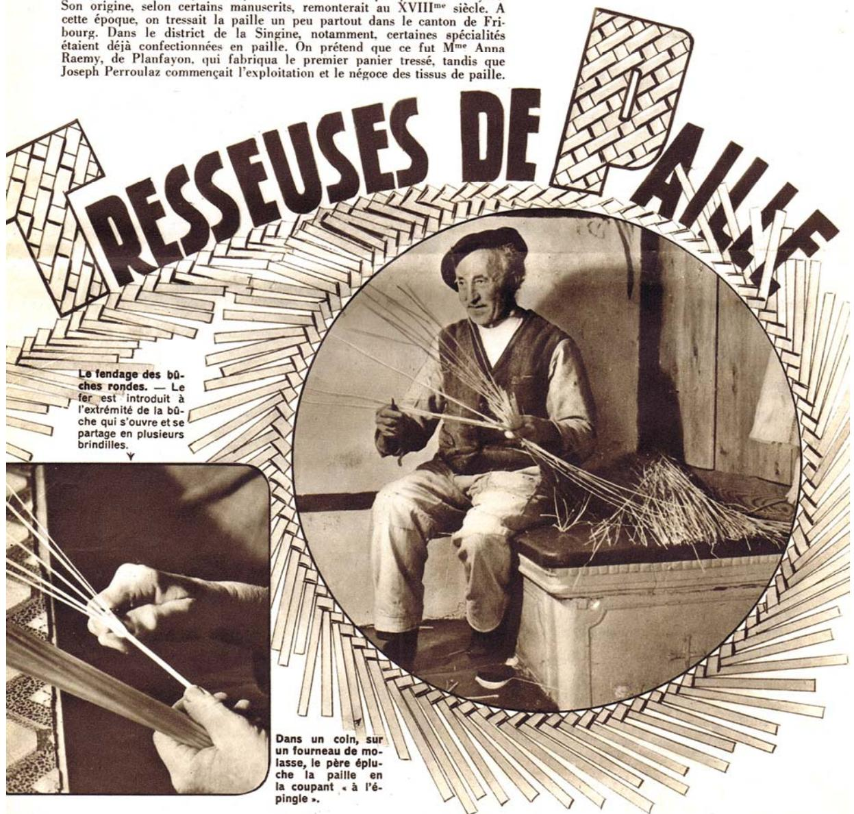
Le fendage des bûches rondes. — Le fer est introduit à l'extrémité de la bûche qui s'ouvre et se partage en plusieurs brindilles.
