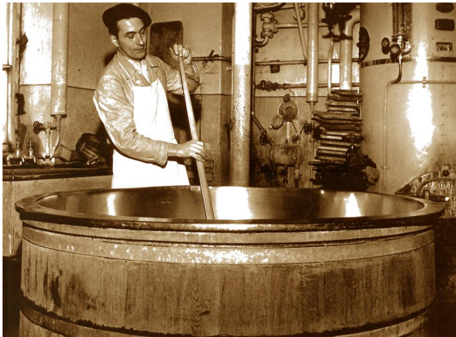
Photo en remplacement de la 3. montrant Gaston, fils de Jules Rochat laitier, maniant le tranche-caillé dans la chaudière. Légende : la caillebotte est coupée menu au moyen du tranche-caillé.
